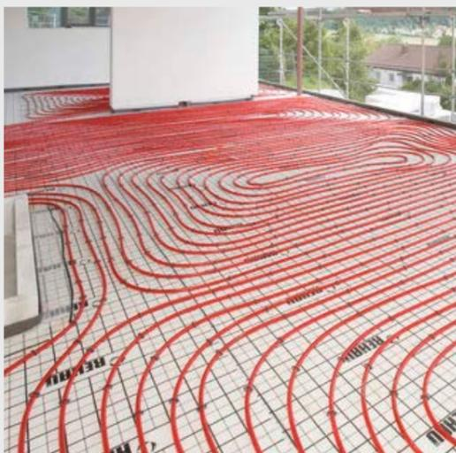
Installation de TERRE RADIANT de REHAU à l'étage de la zone de nuit pour le chauffage et rafraîchissement de la même.
