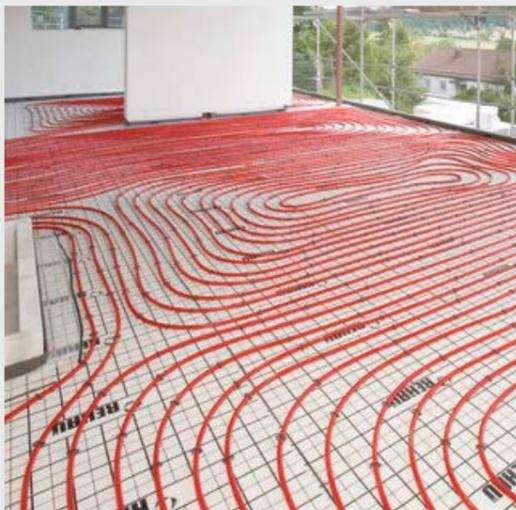
Instalación de SUELO RADIANTE de la casa REHAU en la planta de la zona de noche para la calefacción o refrescamiento de la misma.
